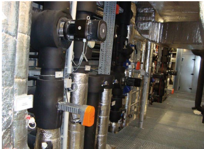
Technikzentrale mit Belimo-Ventilen und Stellantrieben, jeweils mit Sensor-einbindung über MP-Bus
