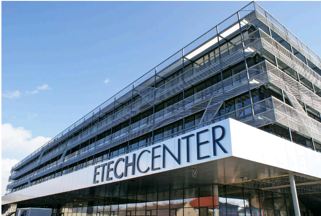
Das neue ETECHCENTER zwischen Eisenbahn- und VOEST-Brücke an der Hafensstraße.
